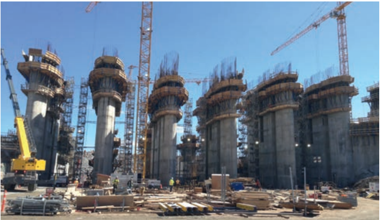
Canada, Progetto Idroelettrico Muskrat Falls.
