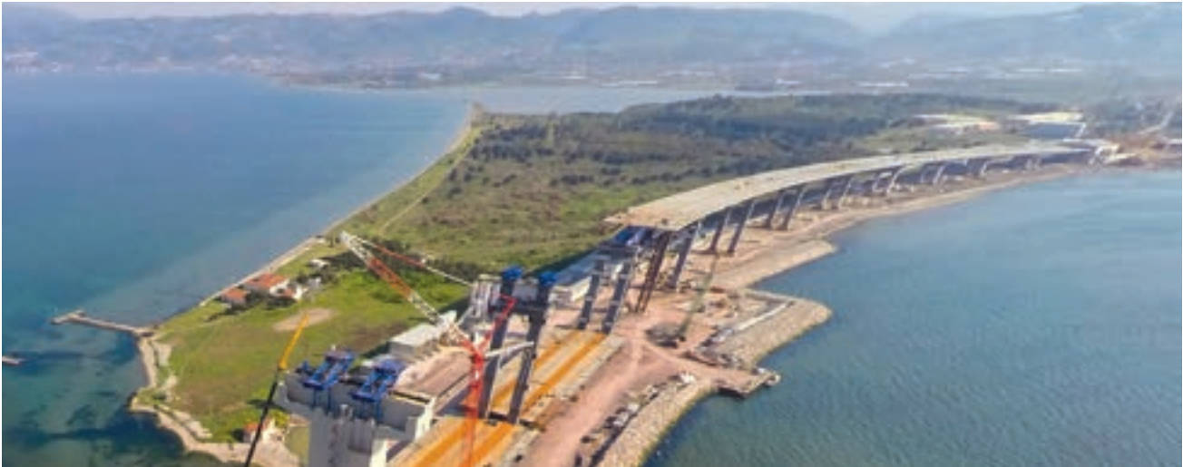
Turchia, Autostrada Gebze-Orhangazi-Izmir.
