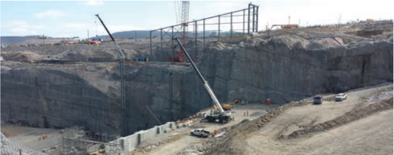
Canada, Progetto Idroelettrico Muskrat Falls.
