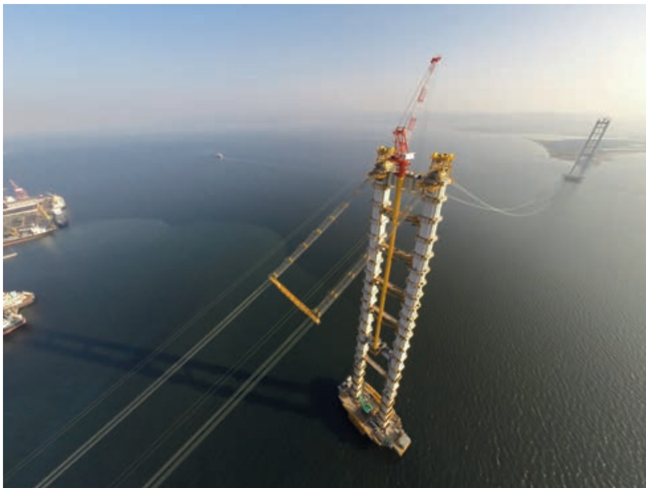
Turchia, Autostrada Gebze-Orhangazi-Izmir (Ponte sulla Baia di Izmit).
