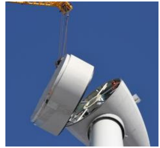
Buddusò –Alà dei Sardi wind farm | Location: Italy
