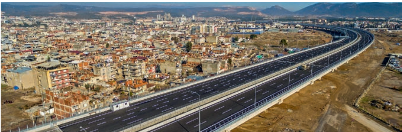
TURCHIA - Autostrada Gebze-Orhangazi-Izmir | Viadotto Bornova.
