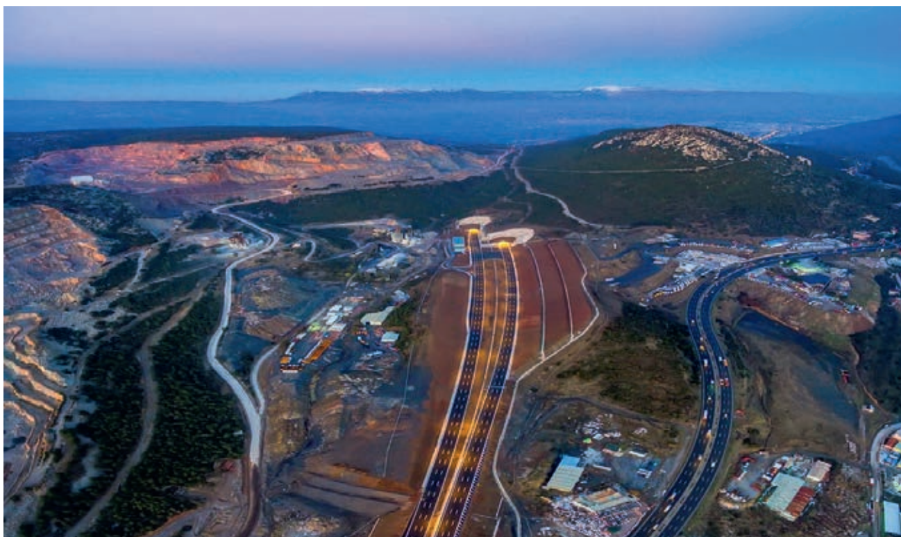
TURCHIA - Autostrada Gebze-Orhangazi-Izmir | Imbocco Tunnel di Belkahve.
