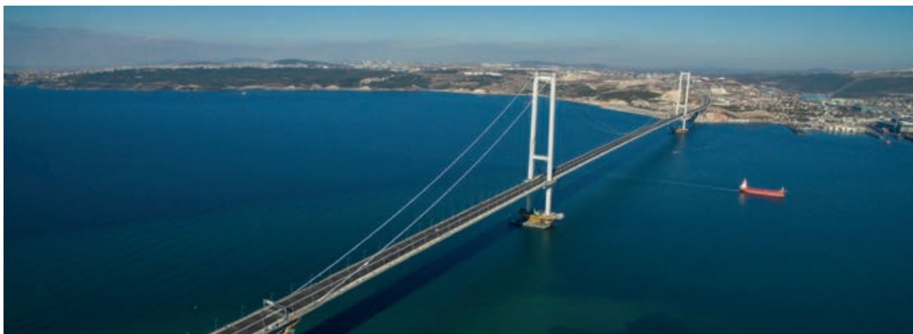
TURCHIA - Autostrada Gebze-Orhangazi-Izmir | Ponte sulla Baia di Izmit.
