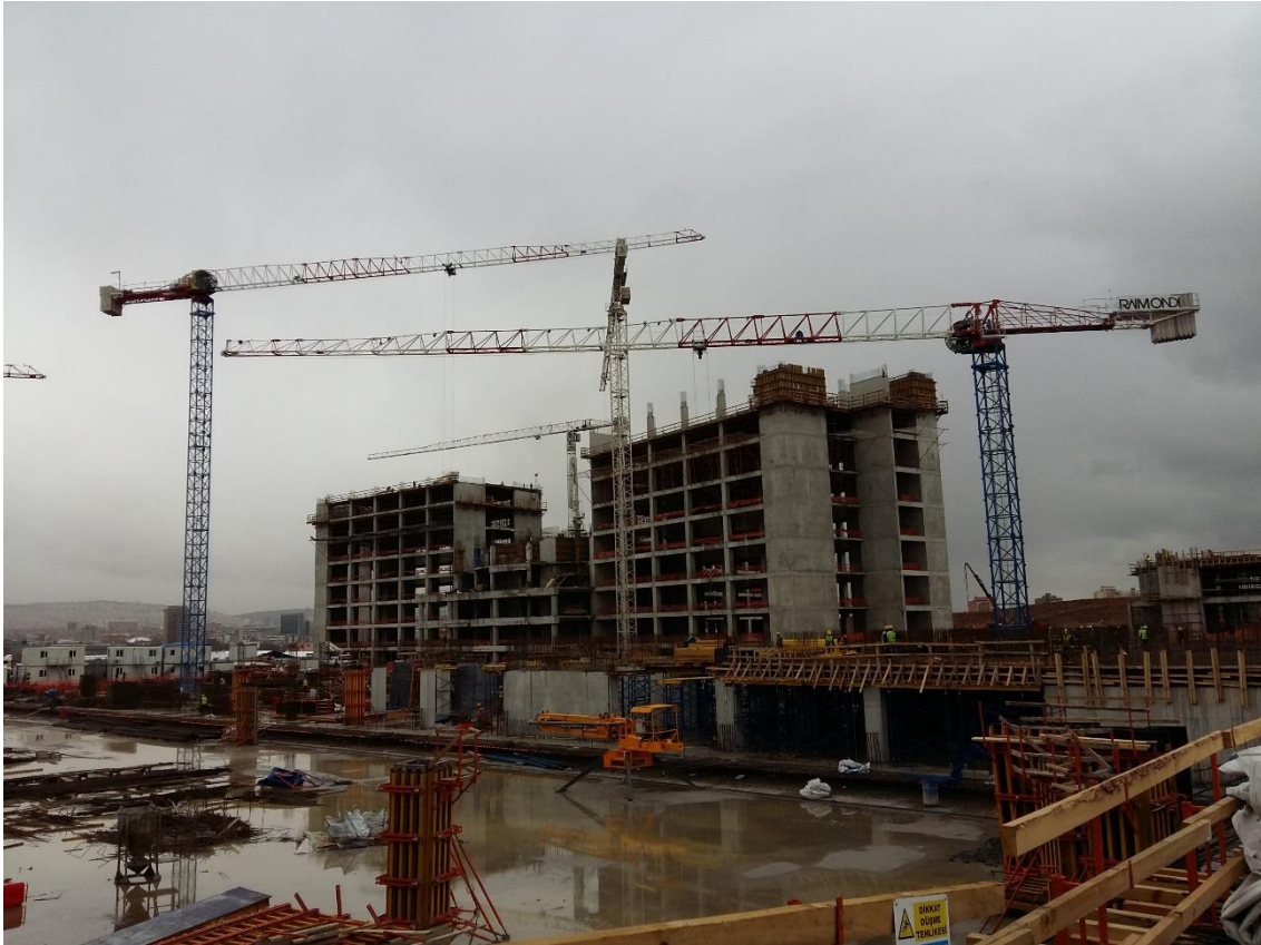
TURCHIA, ETLIK INTEGRATED HEALTH CAMPUS DI ANKARA – Il più grande polo sanitario oggi in costruzione in Europa.
