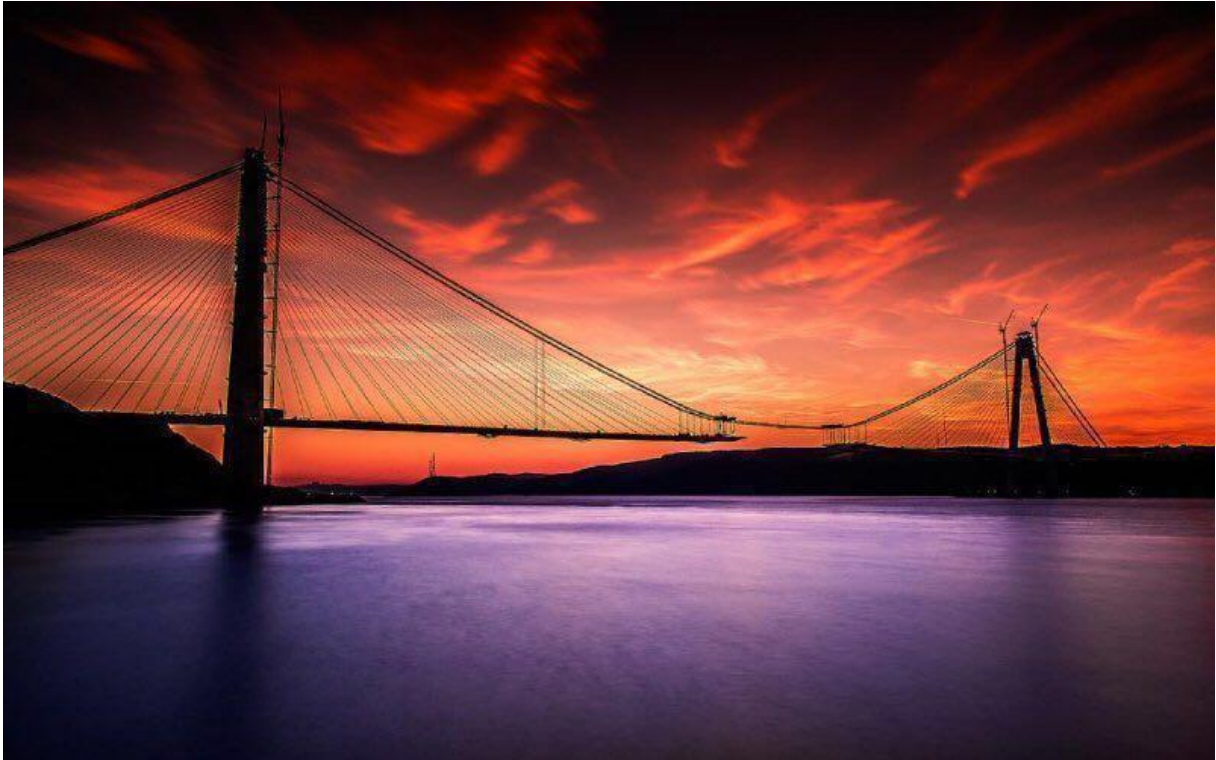
TURCHIA, TERZO PONTE SUL BOSFORO – Il più largo ponte sospeso al mondo.
