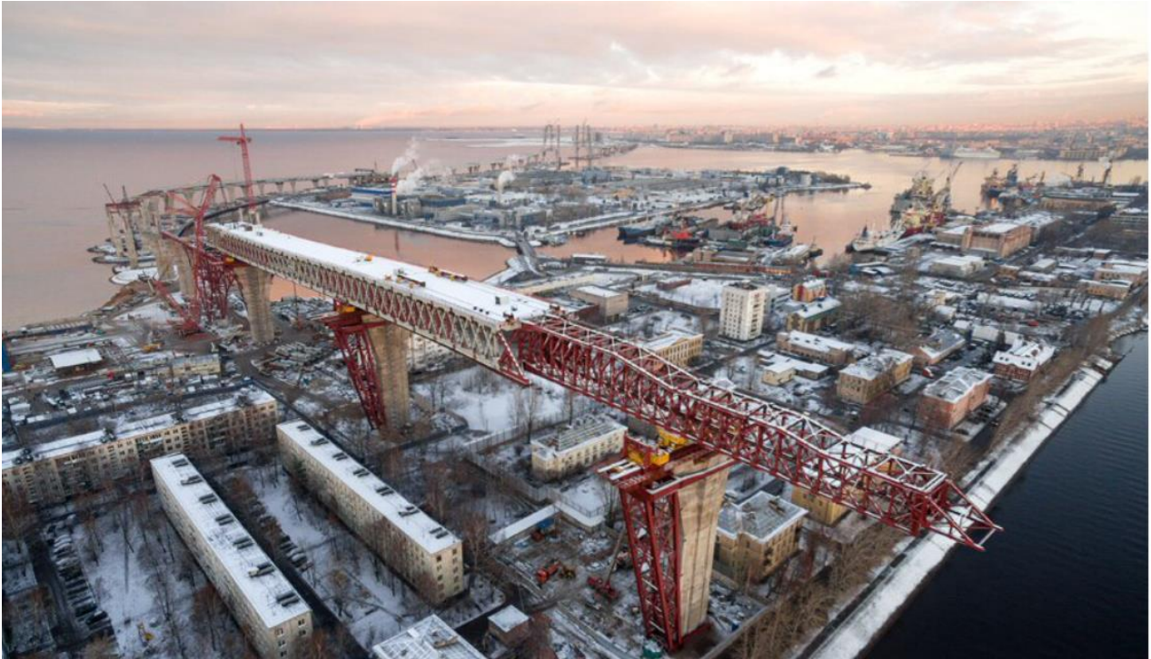
RUSSIA, WHSD DI SAN PIETROBURGO – Realizzato con un complesso sistema di fondazioni a mare.
