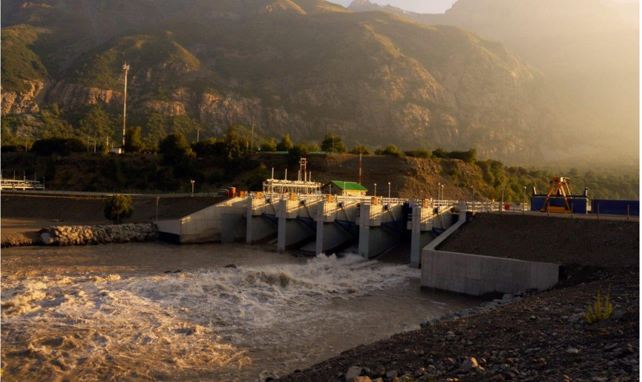
CHACAYES, IMPIANTO IDROELETTRICO DI CHACAYES – Il 1° impianto totalmente eco-compatibile realizzato in Cile.
