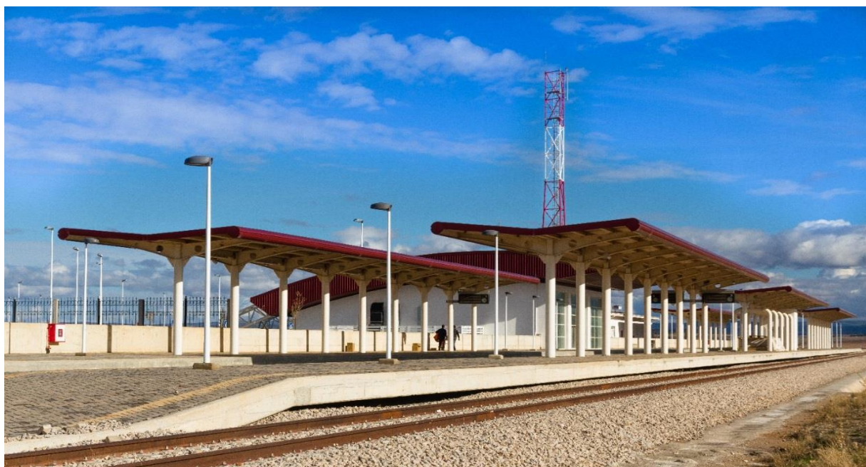
ALGERIA – Ferrovia Saida-Moulay Slissen.
