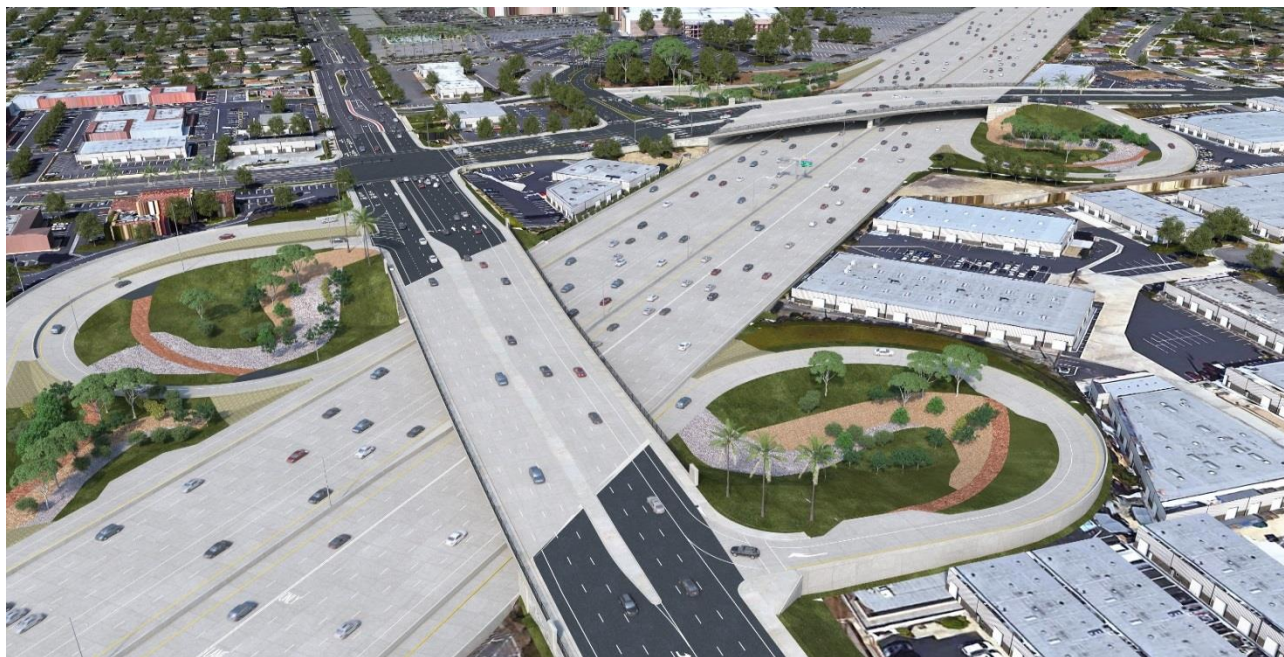
USA (California) – Render dell'Autostrada I-405 di Los Angeles.
