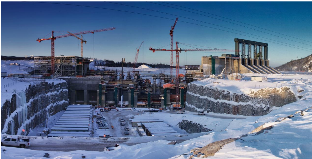
CANADA – Impianto Idroelettrico Muskrat Falls (© Alberto Audisio).
