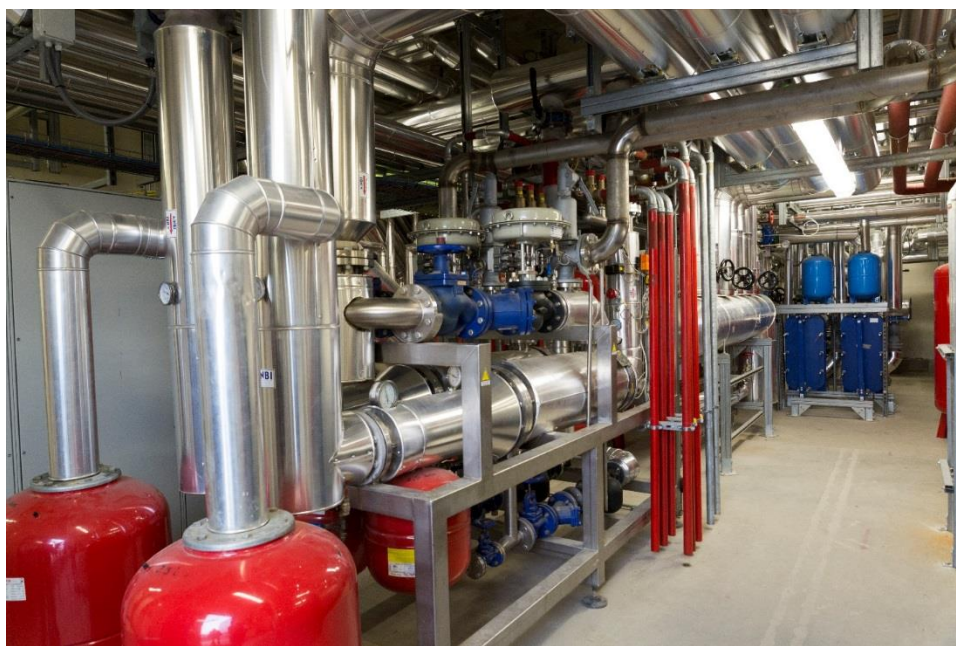
ITALIA – Ospedale della Apuane di Massa-Carrara (Impianti).
