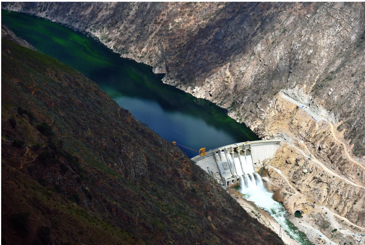
PERÙ – Impianto Idroelettrico di Cerro del Águila.
