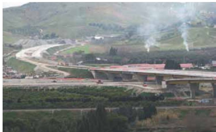
Italia, Strada Statale Jonica Viadotto Corace.
