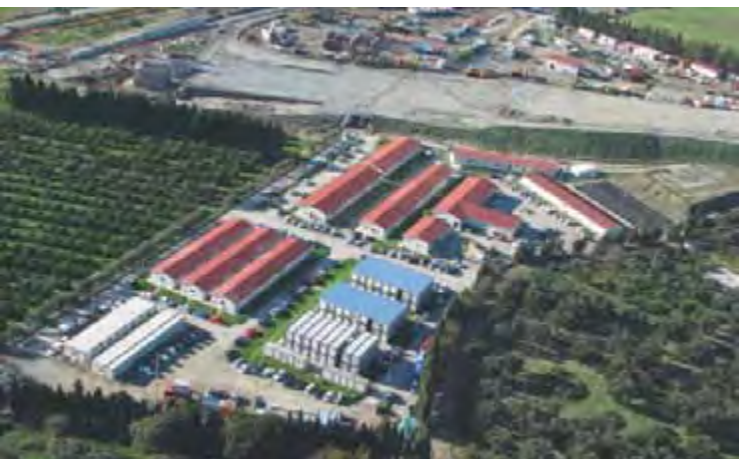
Italia, Strada Statale Jonica Campo Base.
