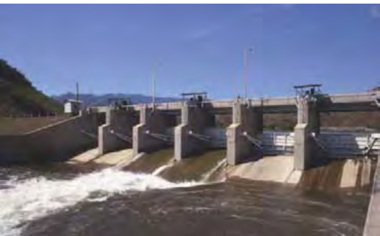
Cile, Impianto idroelettrico di Chacayes.
