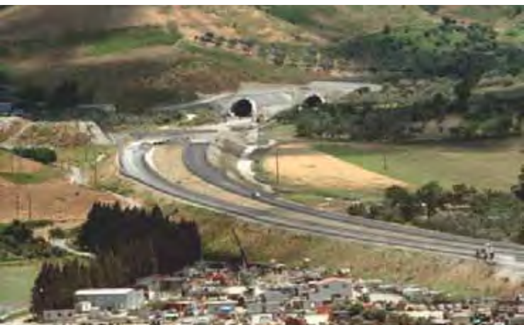
Italia, Strada Statale Jonica (SS-106).
