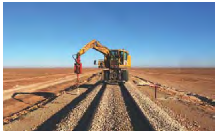
Algeria, Ferrovia Mecheria – Redjem Demouche.
