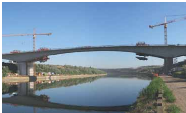
Romania, Autostrada Bucarest – Costanza.
