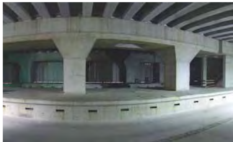
Italia, Passante ferroviario di Torino.
