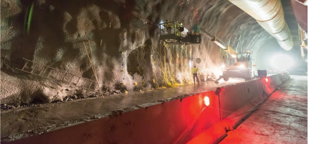
ITALIA – Galleria di Base del Brennero (immagini della volata in galleria effettuata a dicembre 2016).
