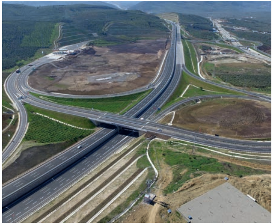
TURCHIA - Autostrada Gebze-Orhangazi-Izmir.
