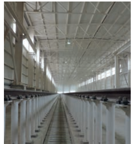
ALGERIA – Ferrovia Saida-Moulay Slissen.
