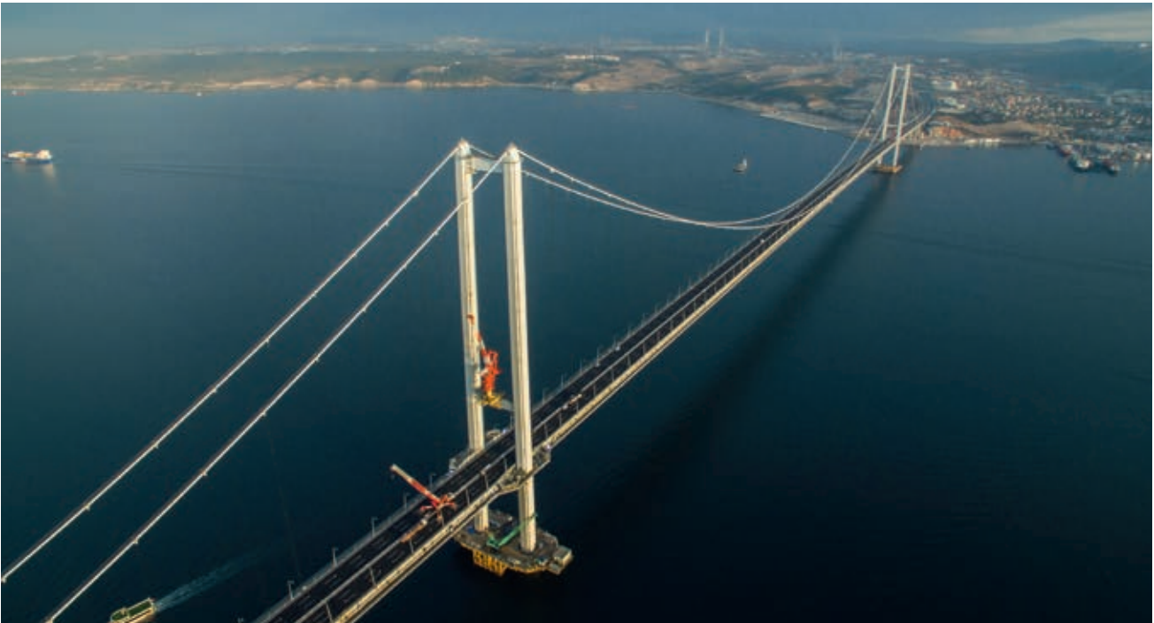
TURCHIA – Autostrada Gebze-Orhangazi-Izmir (Ponte sulla Baia di Izmit).
