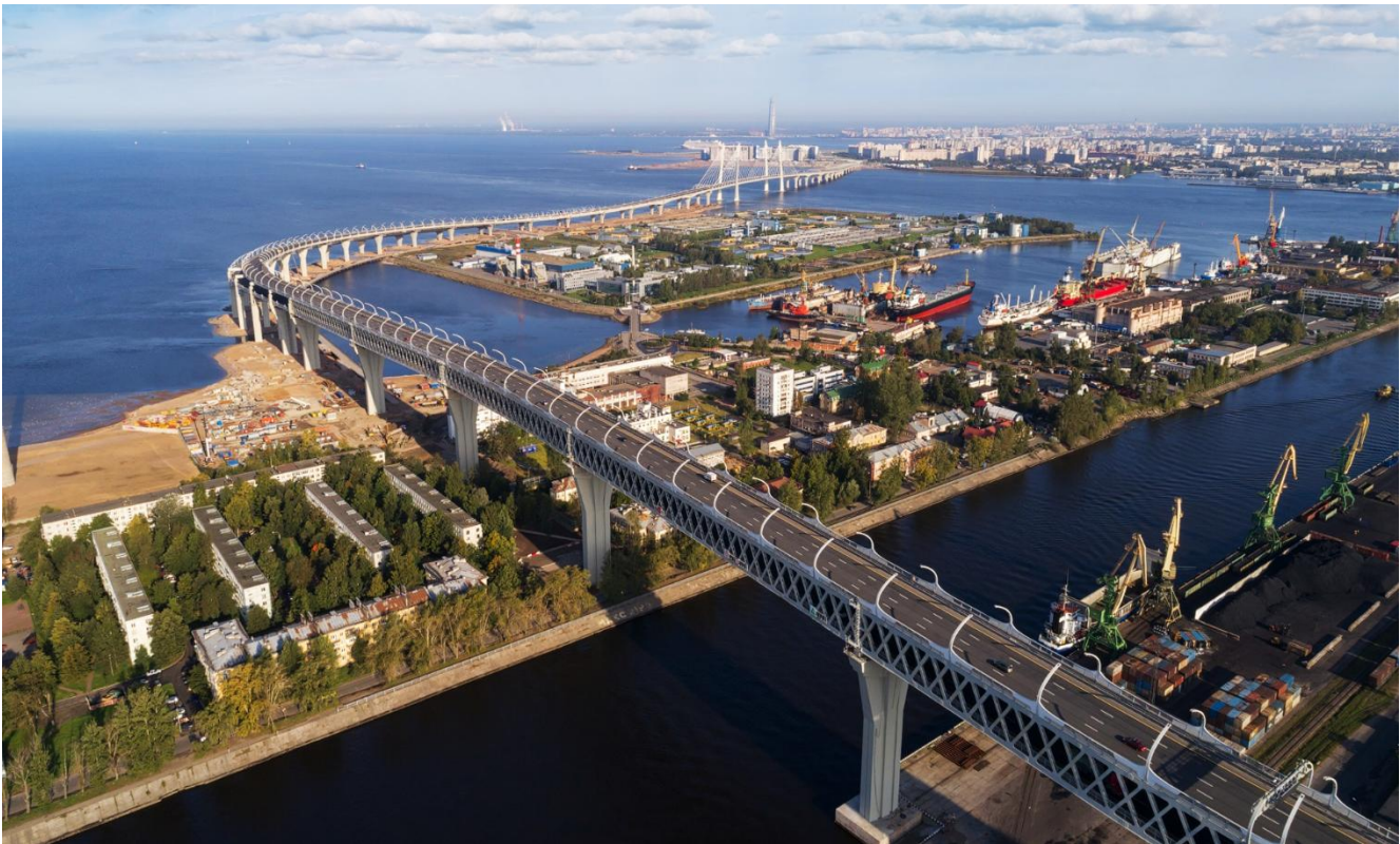
FIGURA 2: AUTOSTRADA GEBZE OTOYOL IZMIR (GOI) - TURCHIA
