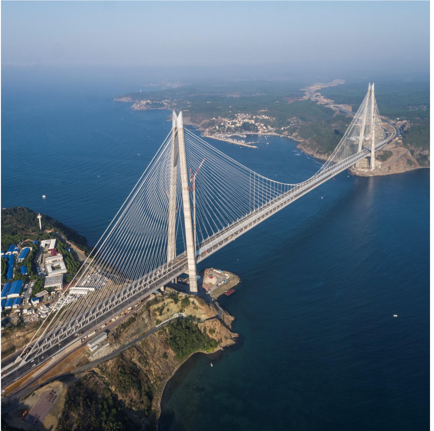
FIGURA - TERZO PONTE SUL BOSFORO - TURCHIA
