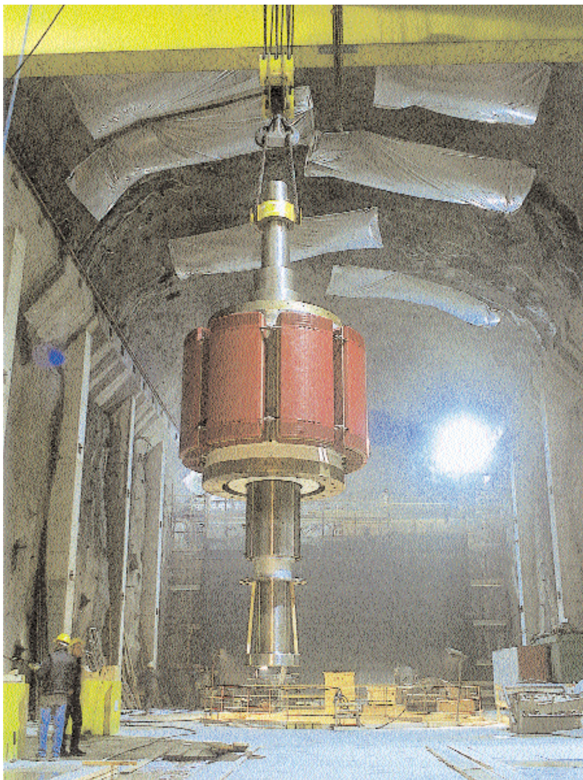
Italia - Impianto idroelettrico di Pont Ventoux: Centrale in caverna - rotore gruppo 1
