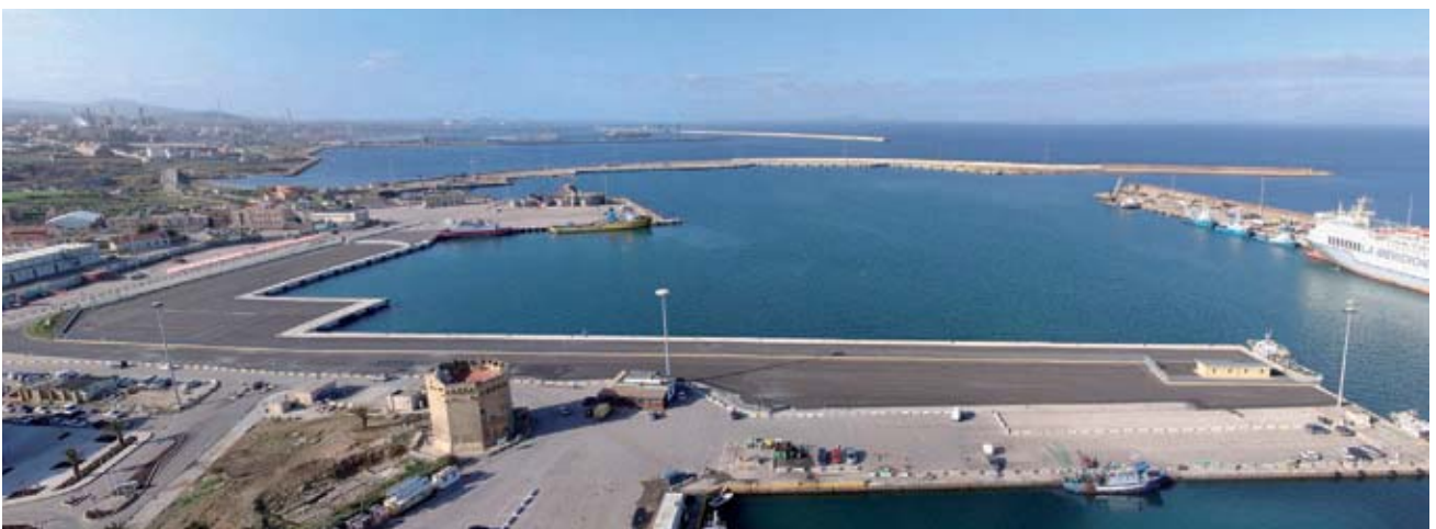
Italia, Porto commerciale di Porto Torres.
