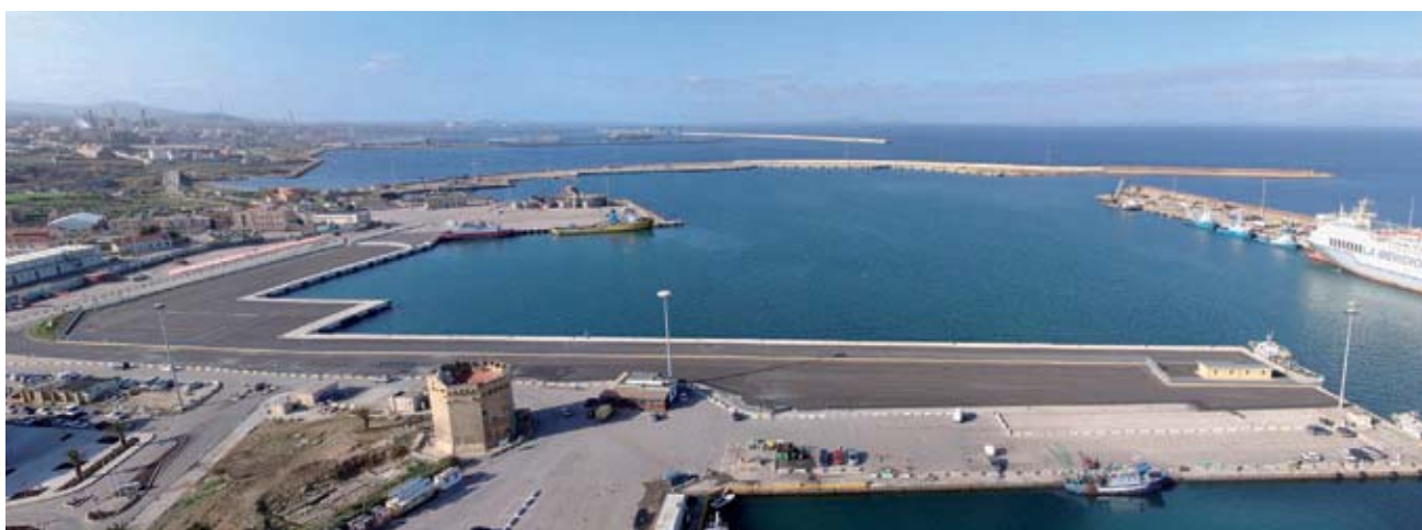
Italia, Porto commerciale di Porto Torres.
