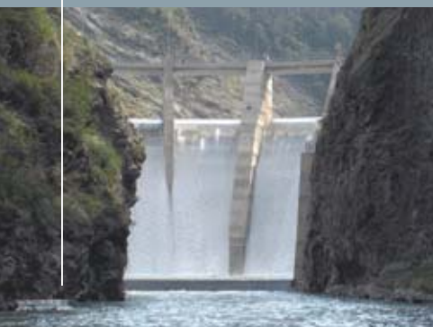
Lavori idraulici e impianti di produzione energetica
