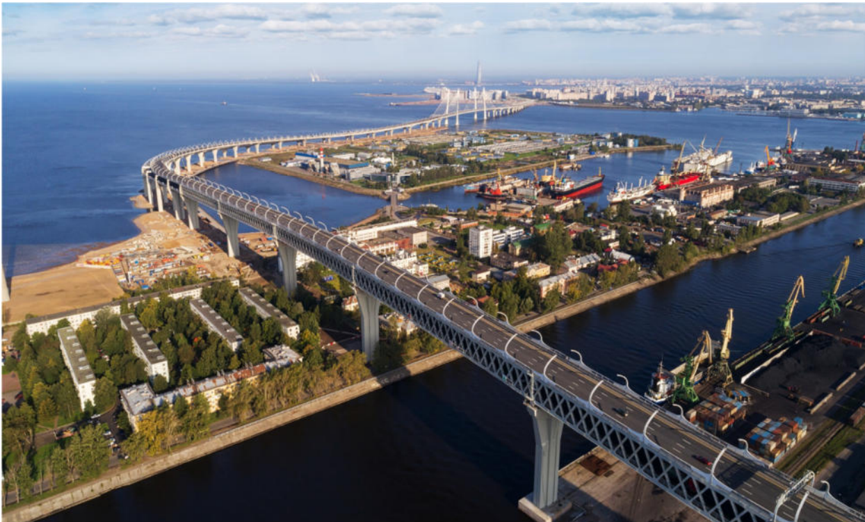
FIGURA 2: AUTOSTRADA GEBZE OTOYOL IZMIR (GOI) - TURCHIA
